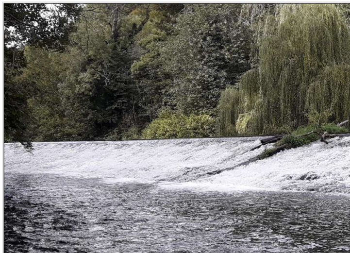
Figure 28. Weir face (TS2).
